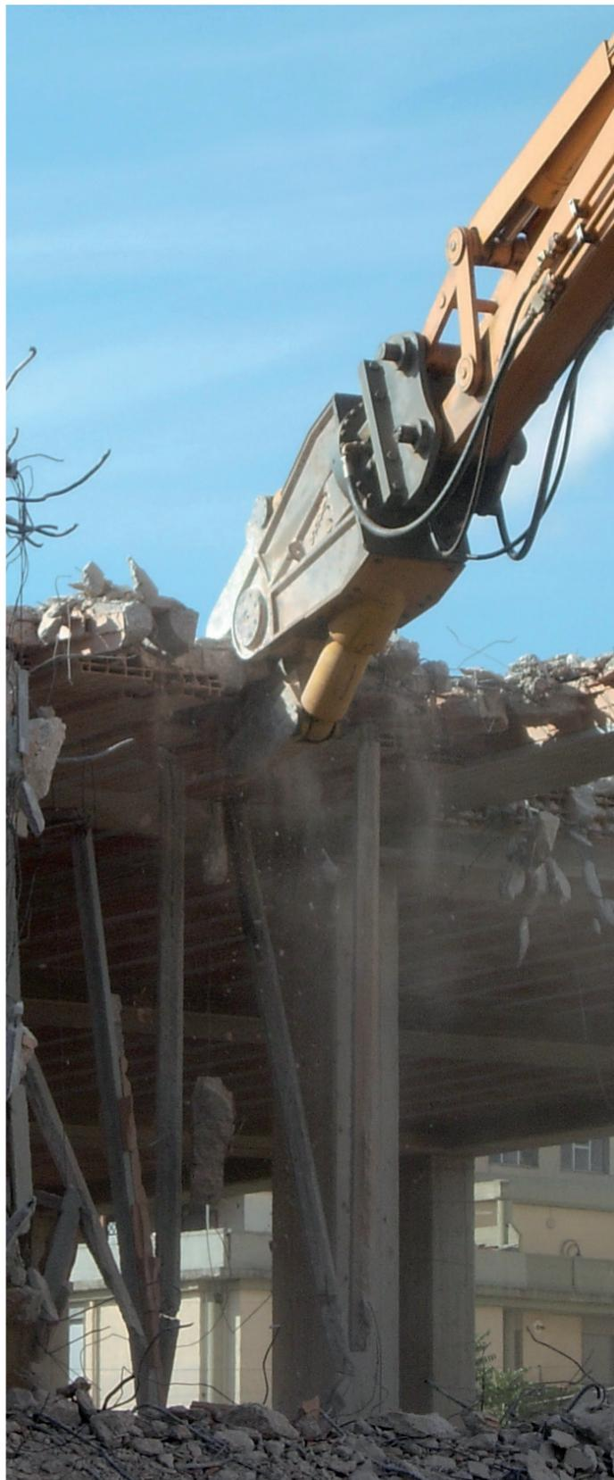
Rotação hidráulica contínua de 360°, com válvula de proteção, que permite uma melhor demolição em todas as condições logísticas e um aprisionamento sempre otimizado dos materiais a serem demolidos
